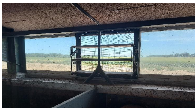
Figur 16. Reglerbart luftintag i danskt vågsstall.
